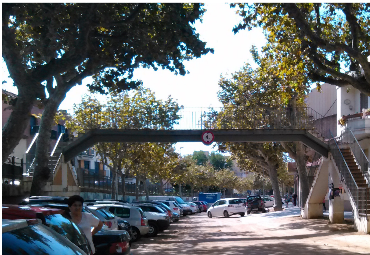
El pont actual que el projecte preveu enderrocar
