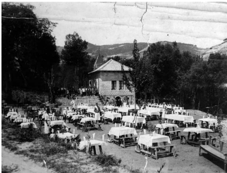
Taules a l'aire lliure amb servei de restauració abans de la construcció de l'edifici del restaurant.
